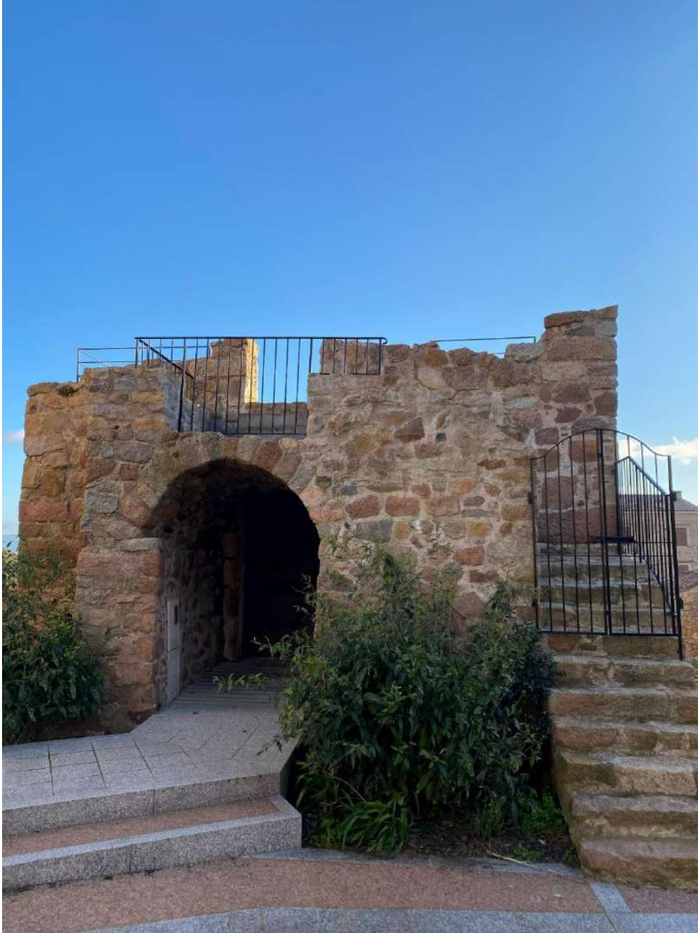
Figure 173. Placette de la tour du Marchesaccio au Village. Cliché : Coline DAVID, 03/2022.
