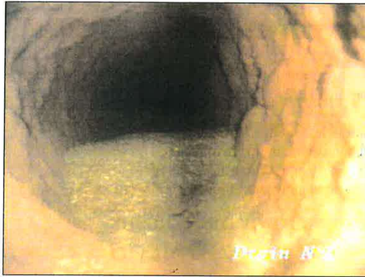
Fig. 7 – Photo tronçon 4 – colmatage et remplissage de sable
