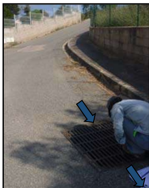
Photo 12 : Vue du réseau enterré
