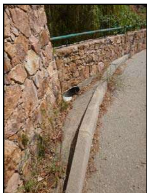
Photo 5 : Vue de l'exutoire à réaménager
