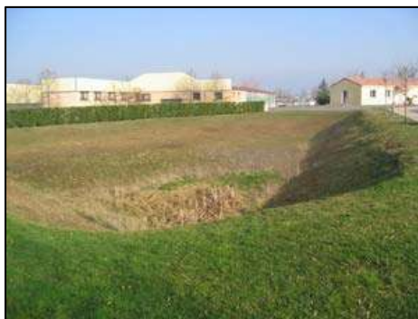
Figure 12 : bassin de rétention en forme de noue
