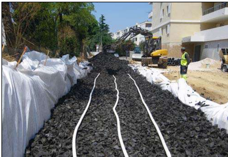
Figure 9 : Exemple de dispositif d'infiltration des eaux pluviales
