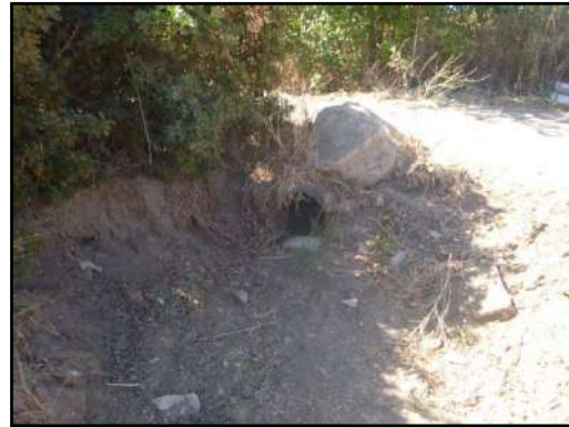
Photo 29 : Vue de l'exutoire
