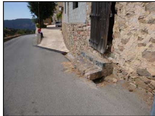
Photo 4 : Vue du départ du réseau sud-est
