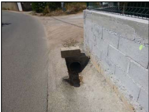
Photo 8 : Vue du départ de la buse
