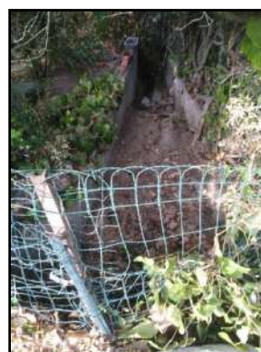
Photo 26 : Vue du talweg d'évacuation
