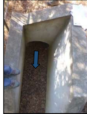
Photo 17 : Vue de l'exutoire du 2 nd réseau
