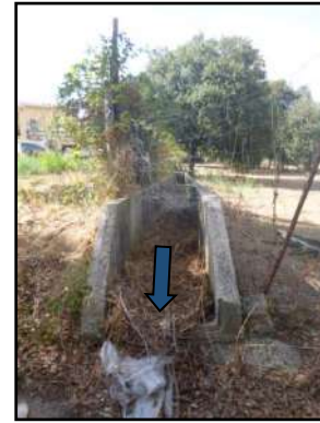
Photo 15 : Vue de la cunette béton
