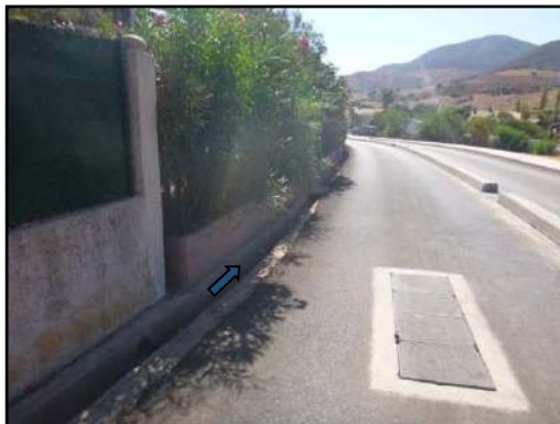
Photo 30 : Vue du caniveau
