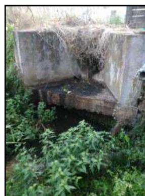
Photo 21 : Vue de l'exutoire
