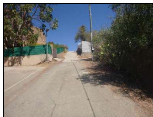
Photo 51 : Vue de l'exutoire de l'OAP n°9
