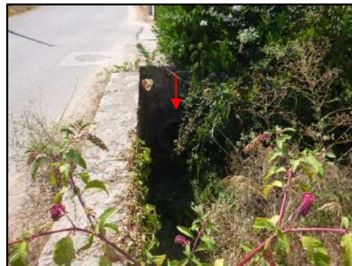
Photo 9 : Vue de l'exutoire
