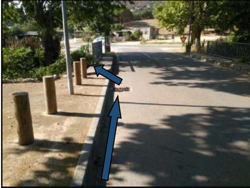
Photo 16 : Vue du 1 er réseau enterré
