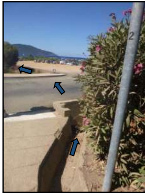
Photo 28 : Vue du passage sous route
