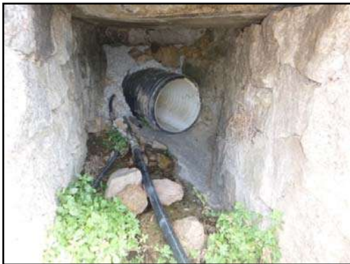
Photo 3 : Vue de l'exutoire du réseau nord-ouest
