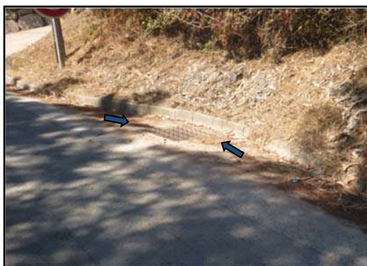
Photo 32 : Vue de la grille
