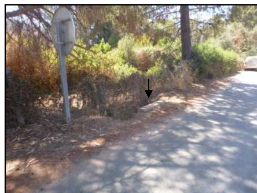
Photo 33 : Vue de l'exutoire
