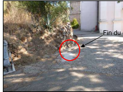
Photo 2 : Vue de l'exutoire du caniveau au niveau de l'église
