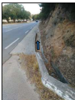
Photo 20 : Vue du caniveau
