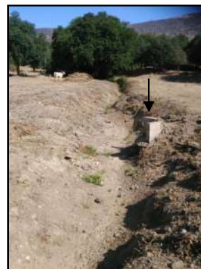
Photo 13 : Vue de l'exutoire
