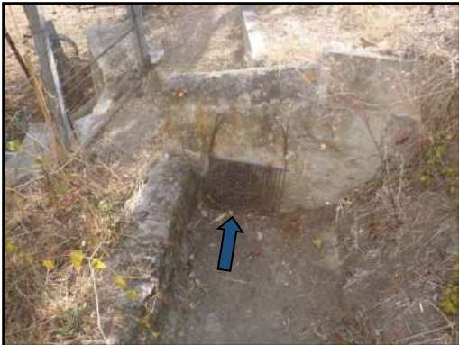
Photo 18 : Vue fin de caniveau/début buse
