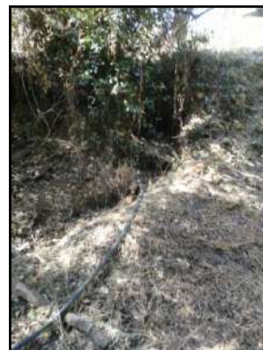
Photo 7 : Vue de l'exutoire
