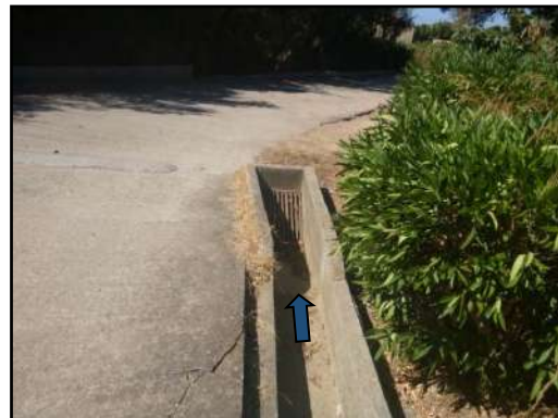
Photo 31 : Vue de la fin du caniveau
