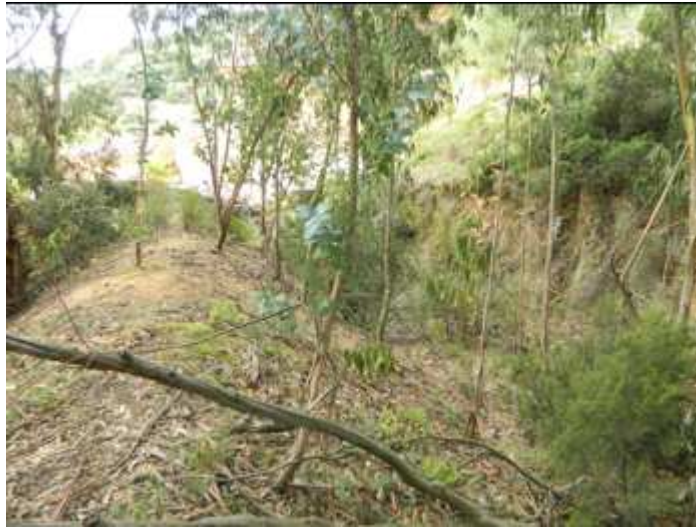
Figure 18 : merlon pare-blocs n°1, au niveau du profil P1
