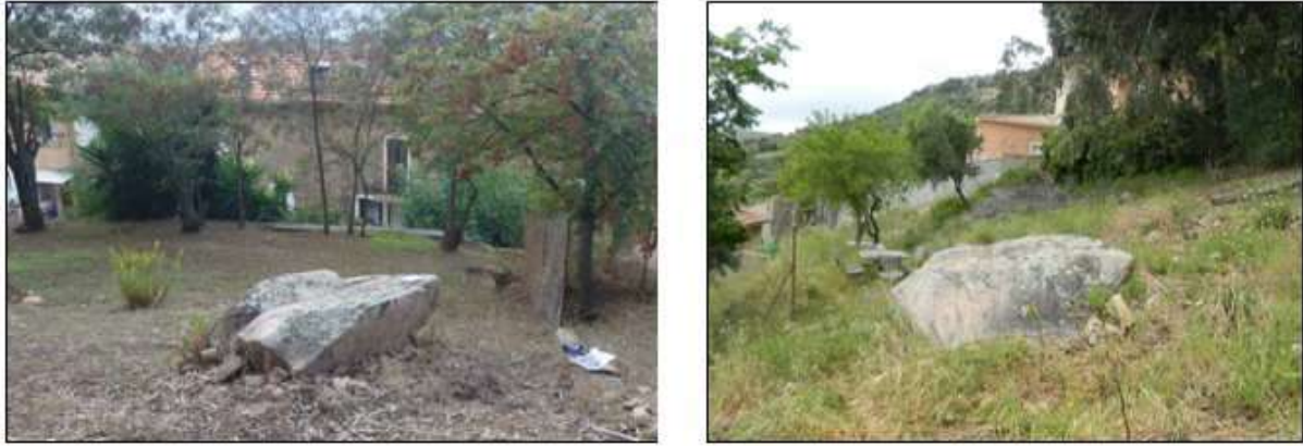
Figure 13 : bloc de près de 10 \text{ t} éboulé en 1982 en amont de Piscia Rossa
