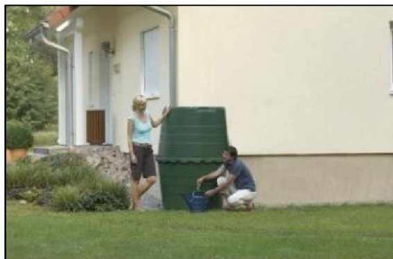
Photo 1 : Cuve de récupération des eaux pluviales
